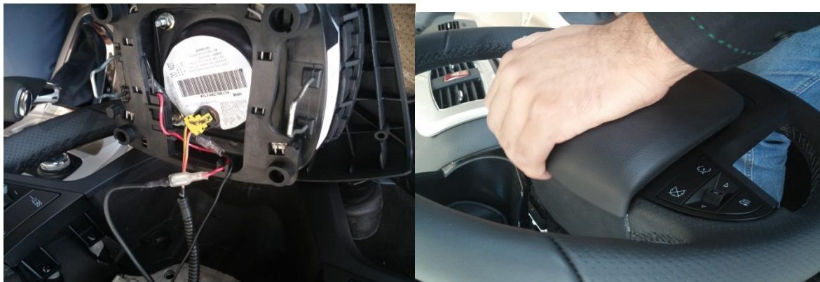
شکل شش: اتصال مجدد کانکتورهای پشت قاب فرمان و نصب ایربگ
